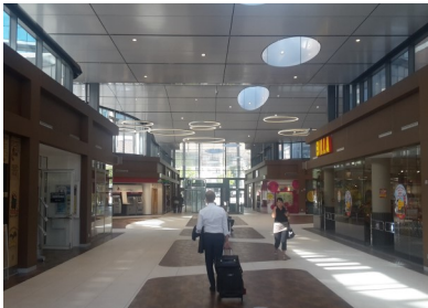
Sanierung Mall im Business Park Vienna (Wienerberg): Bauphysik
