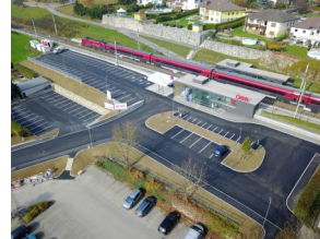
Park&Ride-Anlage Stadt Haag: Detailplanung und ÖBA
