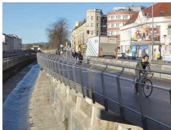
Linke Wienzeile, über dem Wienfluss schwebender Radweg: Planung, Baubegleitung
