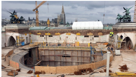
Sanierung Parlament Wien: Generalplanung durch GP Jabornegg & Pálffy / AXIS ingenieurleistungen
