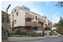
1140 Wien, Mühbergstraße 18: Tragwerksplanung, Bauphysik, Prüferingenieur, Örtliche Bauaufsicht
