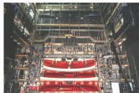
Volksoper Wien, Umbau Portalzone: Tragwerksplanung
