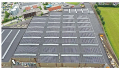
Fa. Welser, Gresten: Photovoltaik-Anlage auf bestehenden Hallendächern
