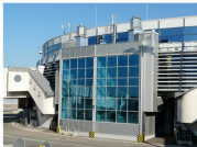
Flughafen Wien, Zubau Busgates Pier West: Generalplaner
