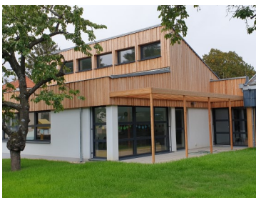
2540 Vöslau-Gainfam, Erweiterung Kindergarten in Holzbauweise: Tragwerksplanung
