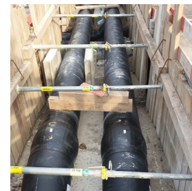
1020 Wien, Nordbahnhof Ost: Ausbau Fernwärme und Fernkälte
