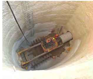
1030 Wien, Strohgasse, Rohrpressung für Leitungsquerung: Generalplanung und ÖBA
