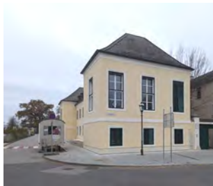
2361 Laxenburg, Schloßplatz 14: Fassadensanierung, Bauphysik und ÖBA
