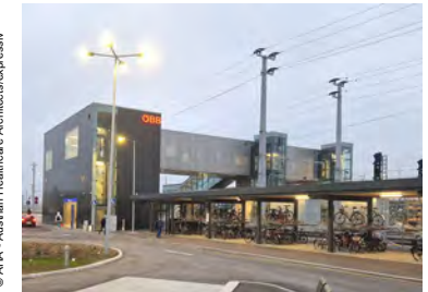
Bahnhof 2440 Gramatneusiedl: Eisenbahnrechtliches Gutachten zur Inbetriebnahme
