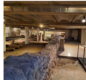
Salzburg, Alte Residenz Domquartier, Sanierung Grabungsmuseum: Tragwerksplanung, Bauphysik und Brandschutz
